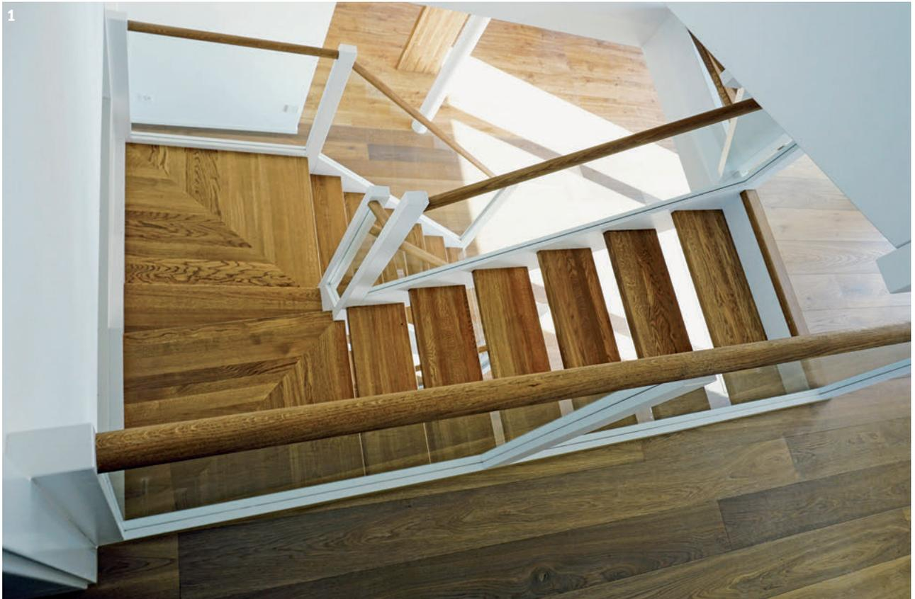
**1** Bei der Holzwangentreppe mit Zwischenpodesten wurde Glas als Kinderschutzleiste, Geländerfüllung und Absturzsicherung verwendet. Stufen, Podeste und Handlauf sind aus Eichenholz; Wangen und Pfosten aus Buchenholz. *Columbus*
