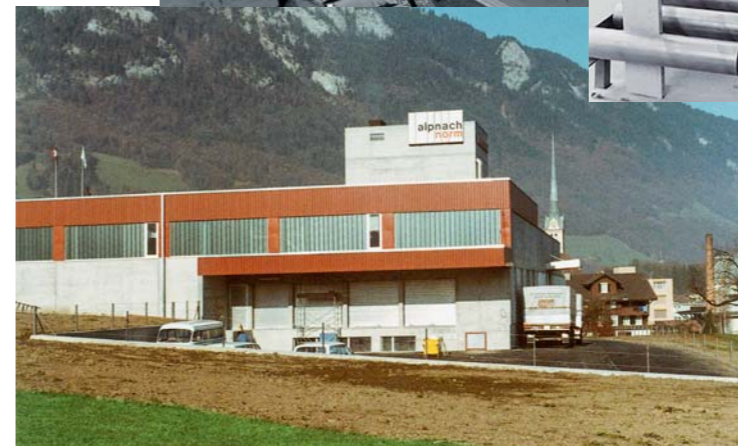
Lager und Spedition: Zusammen mit dem Scheddach-Produktionsgebäude wird 1970 auch ein zweites Lagerhaus mit Spedition und Silo-Neubau errichtet.
